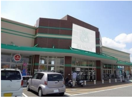
種別：スーパーマーケット 地域：福岡県 施工箇所：折板屋根（N-95）
